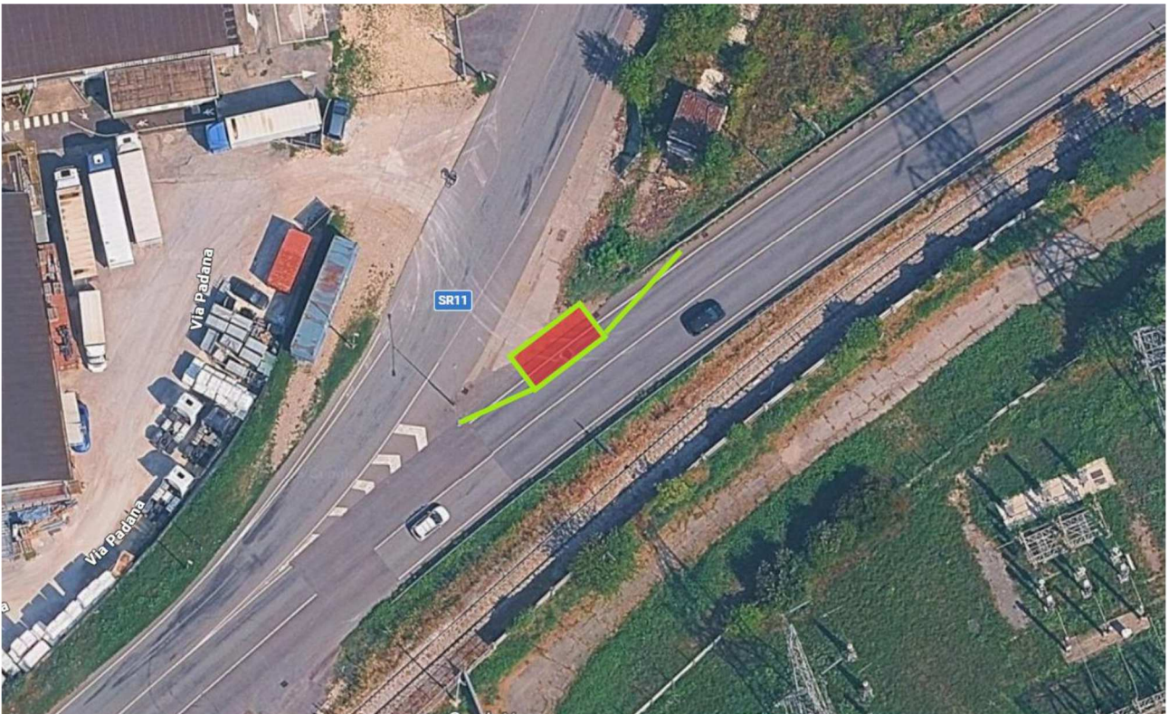
Cantiere sul raccordo tra Strada Regionale n. 11 Padana Superiore (Marghera) e la rotonda presente a est di via Cruto
