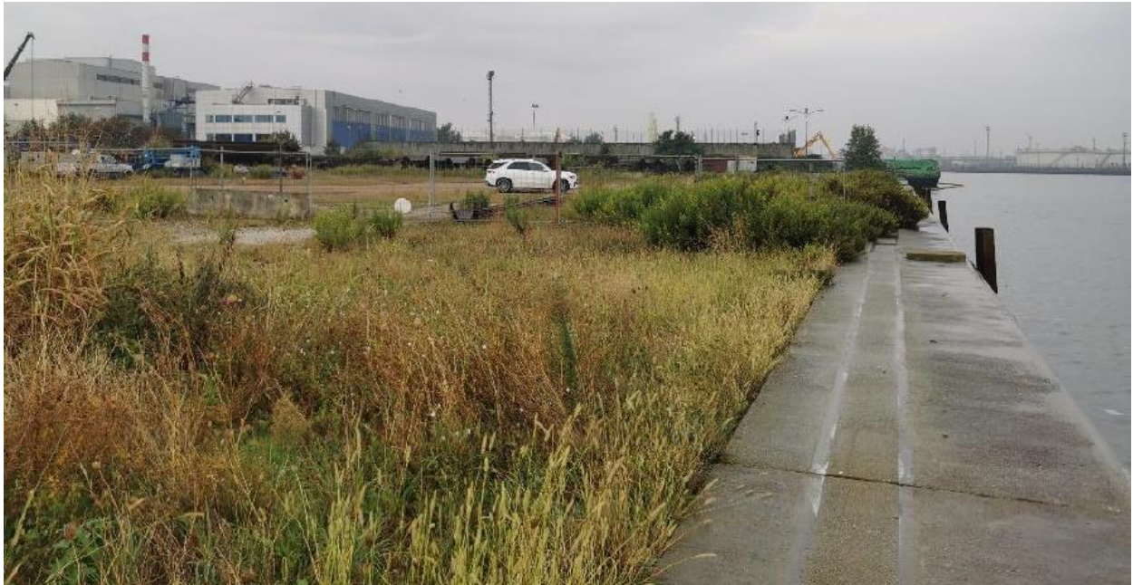
Figura 3: Stato attuale dell'area e della banchina
