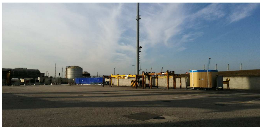
Vista dell'area interessata dall'installazione del nuovo terminal
