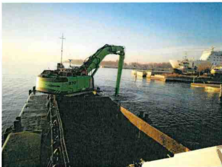
Figura 2- Lavori lungo il Canale Malamocco Marghera
