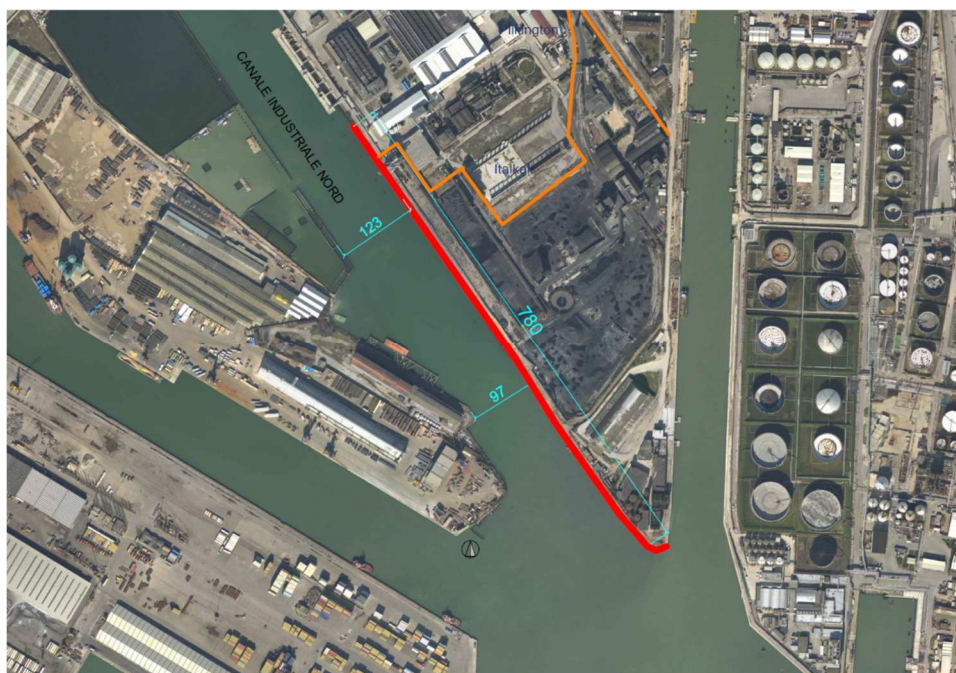
Figura 9 Tratto di banchina interessato dagli interventi di 2 a fase
