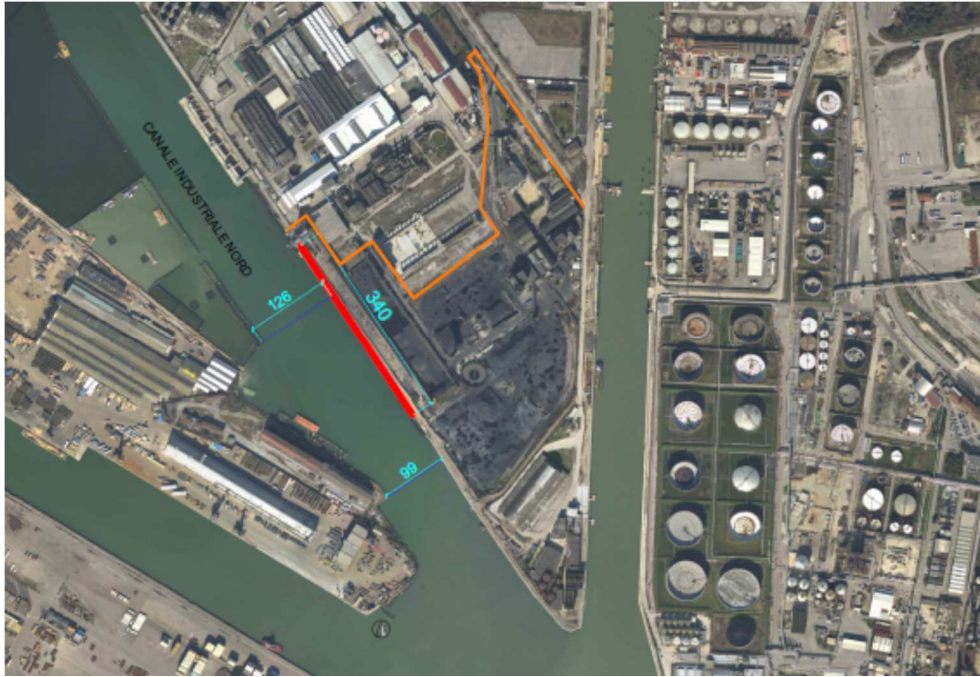
Figura 11 Tratto di banchina interessato dagli interventi di 1 a fase
