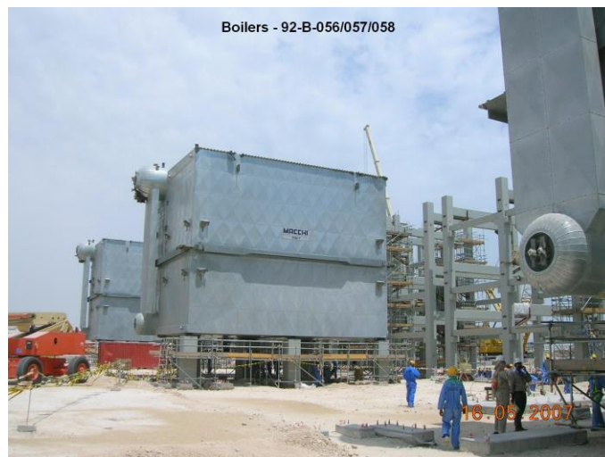
Impianto di produzione riscaldamento (megacaldaia)
