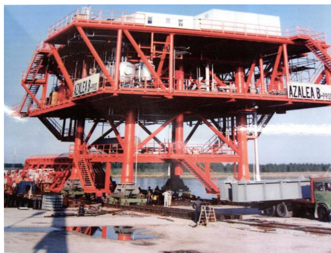
Struttura reticolare metallica destinata ad impianto produttivo
