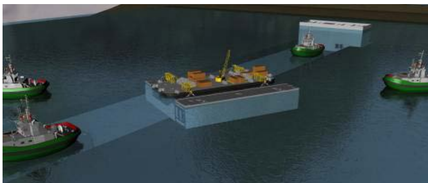
Fig.23: rendering della fase di posa dei cassoni del MoSE. Fonte Grandi Lavori Fincosit
