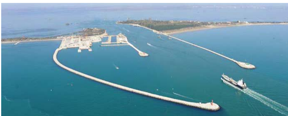
Fig.22: foto area della bocca di Porto di Malamocco con la conca di navigazione
